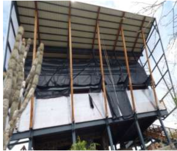
Fotografía LBS 13. Contruido por Arq. Sandra Andrade
